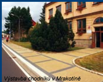
Výstavba chodníků v Mrakotíně
