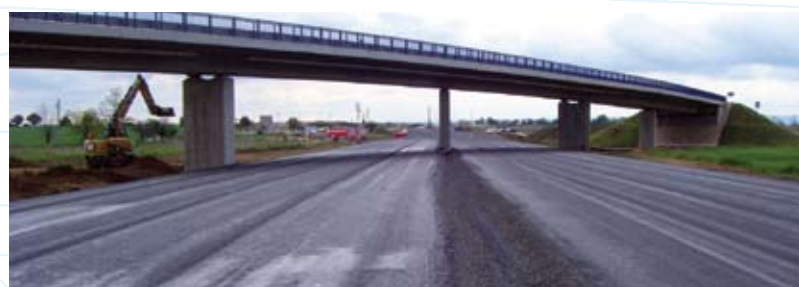
Most na původní silnici I/7 přes rychlostní silnici R7
