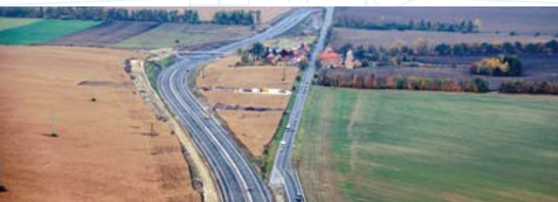
Celkový pohled na stavbu Sulec, obchvat
