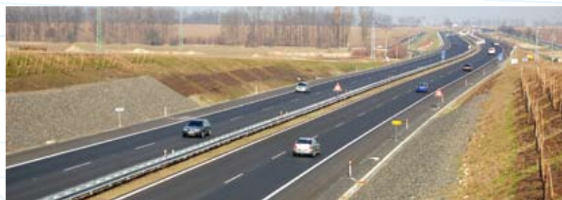
Před koncem stavby, směr Chomutov
