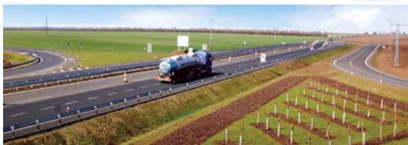
Konec stavby, směr Chomutov
