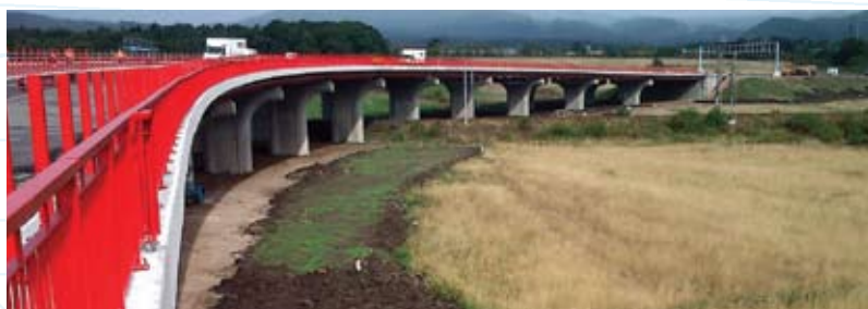
Estakáda přes železniční trať Chomutov–Cheb
