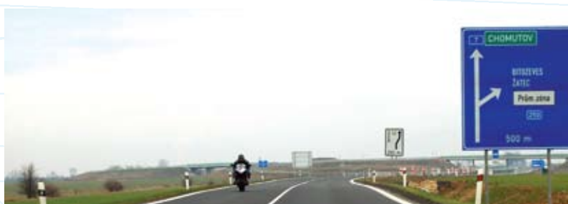
Směr Chomutov, před křižovatkou u Bitozevesi
